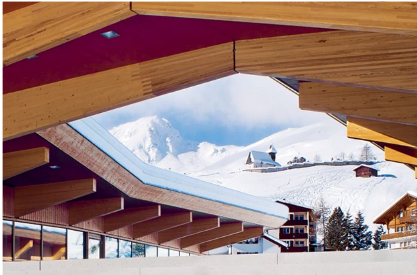
Vom Wettbewerb «Laubholz» des Aktionsplans Holz ausgezeichnetes Gebäude einer Skischule in Arosa (GR). Der markante Holzbau wurde als Brettschichtkonstruktion aus Esche erstellt. Die Träger müssen grossen Schneelasten standhalten und weisen dank dieser Holzart einen verhältnismässig geringen Querschnitt auf.
