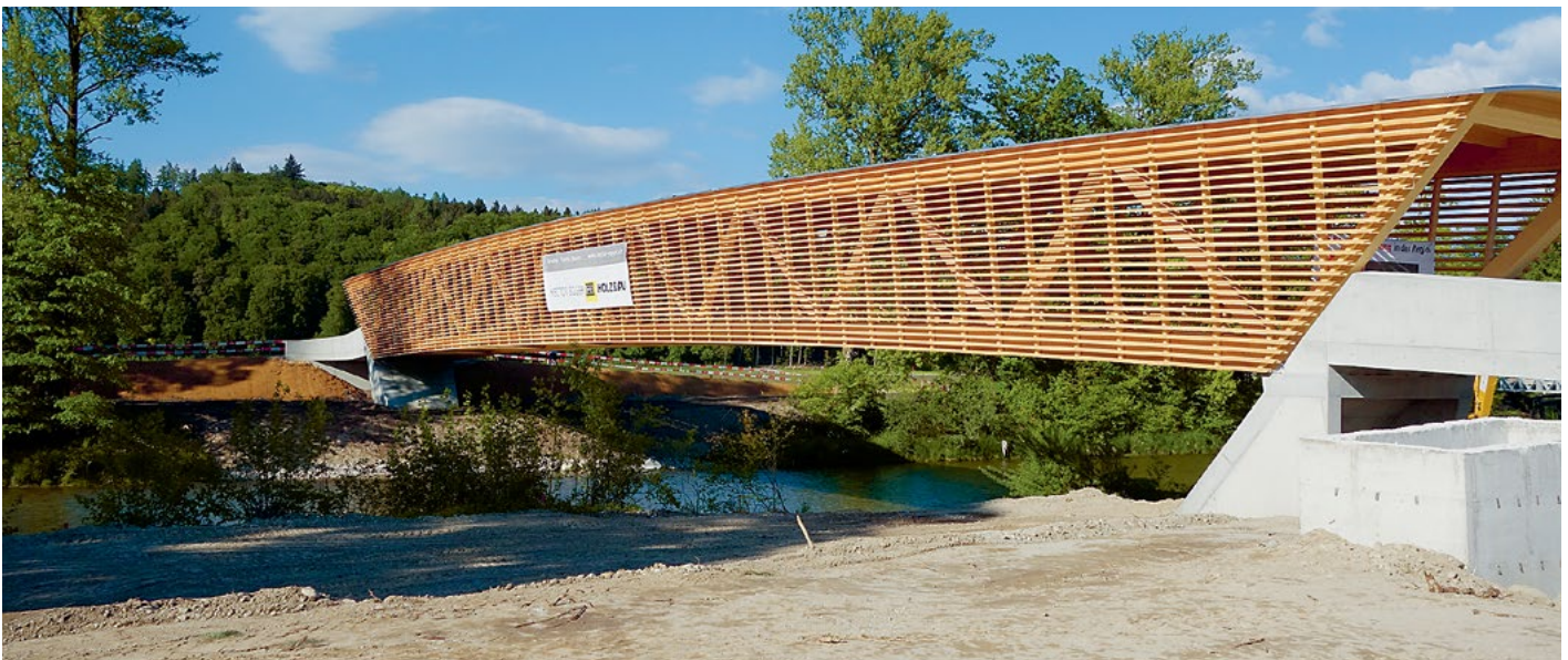
Brücken bauen mit Eschenholz: Velo- und Fussgängerbrücke über die Emme zwischen Burgdorf und Kirchberg (BE).
