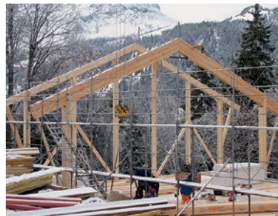
Landwirtschaftliches Ökonomiegebäude aus Buchenholz in Lauenen (BE): fertiggestellt (oben) und während der Montage (unten).
