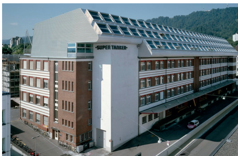
III. 10 Supertanker: transformation et surélévation (2007) en bois d'un entrepôt existant à Zurich Binz (crédit photo: Stücheli Architekten AG)
