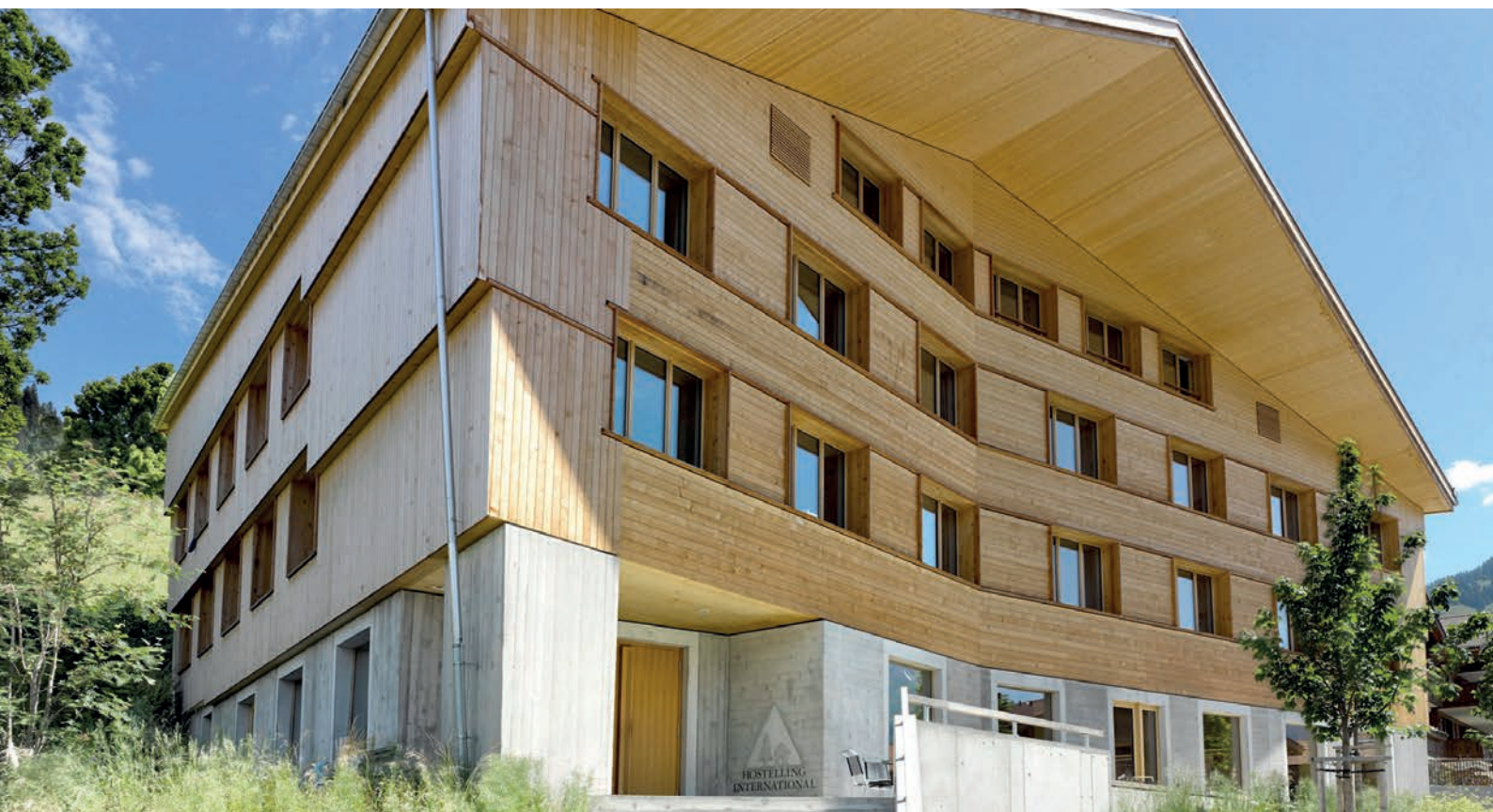
III. 2 Conçue par le bureau bernois Bürgi Schärer Architektur und Planung, l'auberge de jeunesse de Gstaad Saanenland, qui a ouvert ses portes en 2014, est une interprétation moderne des chalets traditionnels de la région. Il s'agit d'une construction hybride alliant béton, maçonnerie et bois. Les façades et le toit sont constitués d'éléments en bois préfabriqués assurant une excellente isolation thermique. (crédit photo: BÜRGI SCHÄRER Architektur und Planung AG, Alexander Gempeler)
