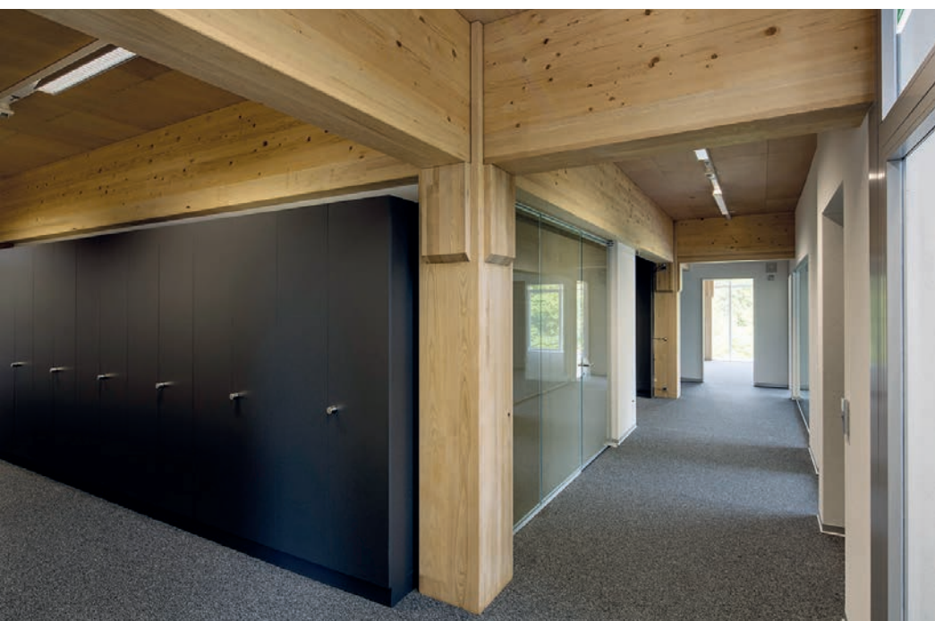
III. 3 Nouveau bâtiment à l'EPF Zurich (House of Natural Resources) construit avec des éléments structurels en bois de feuillus (frêne et hêtre) (crédit photo: EPF Zurich / Marco Carocari)
